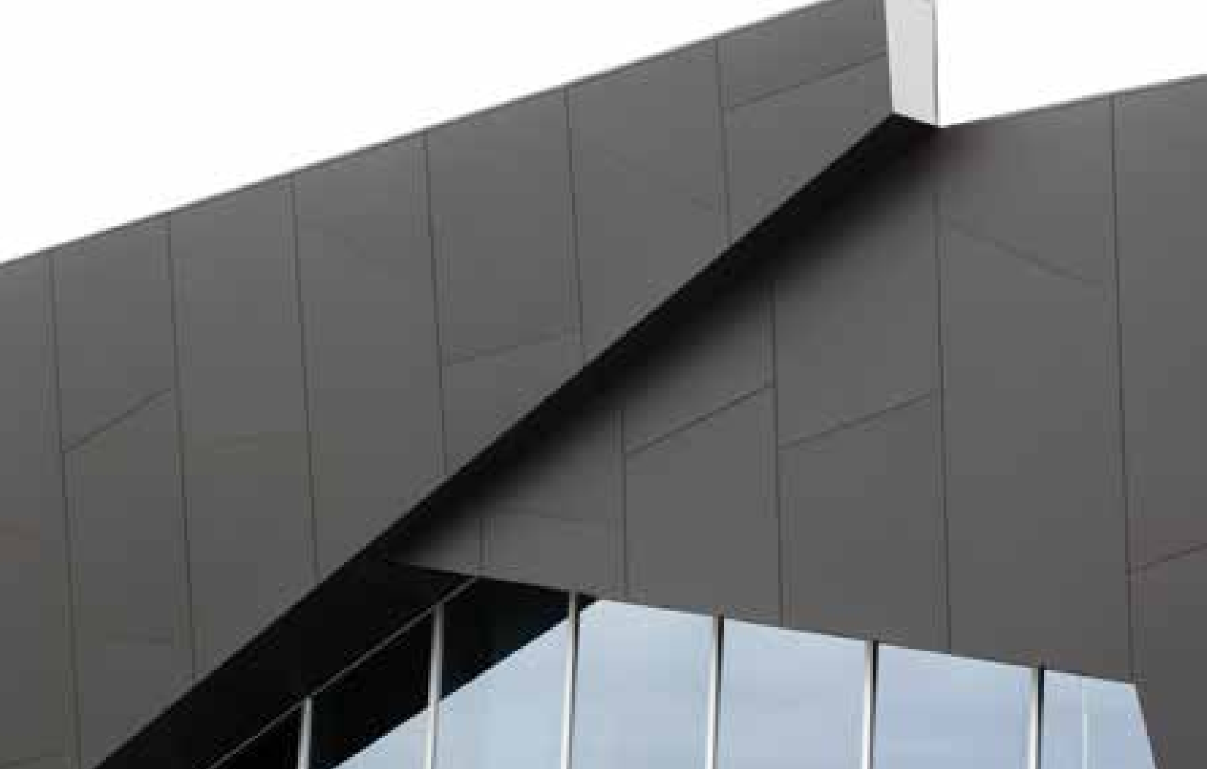
Lorenzoni Srl in Bedizzole – concealed fixing system, Ahmtaler Fassaden-Balkone Ahmtaler Fassaden-Balkone, Design Outlet Brenner, Italien
